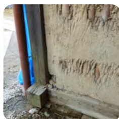
基礎・土台の診断
