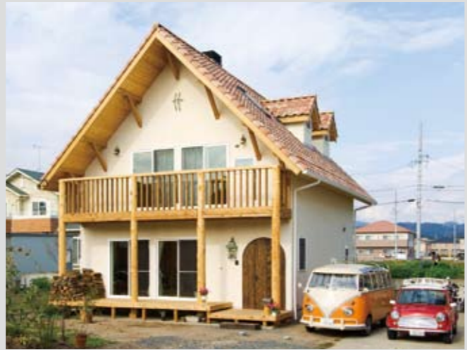
模型の家が完成すると、この通り。建築途中も気になる箇所があれば快く変更に応じてくれる対応の誠実さで施主との信頼関係がさらに育まれているようだ。施工実例
